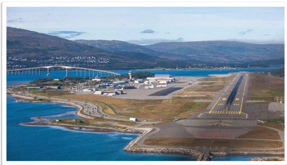
Figur 3 Innflygningen til Tromsø lufthavn fra sør (Kilde: Avinor)
