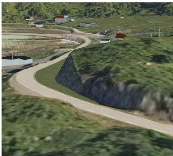
Figur 10 Ny situasjon – etter steinuttak
